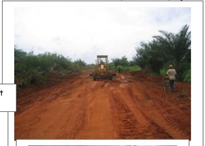
Elargissement mécanisé des pistes et creusement manuel des fossés
